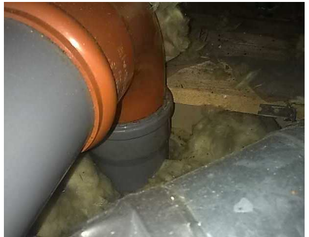
Putkiläpiviennit yläpohjassa
