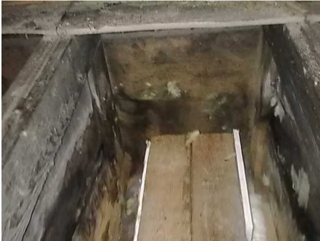
Asuntojen välisen seinän kohta yläpohjassa.
