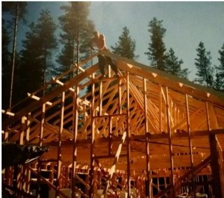
1993, omakotitalon rakentamista huippu timpurin opissa
